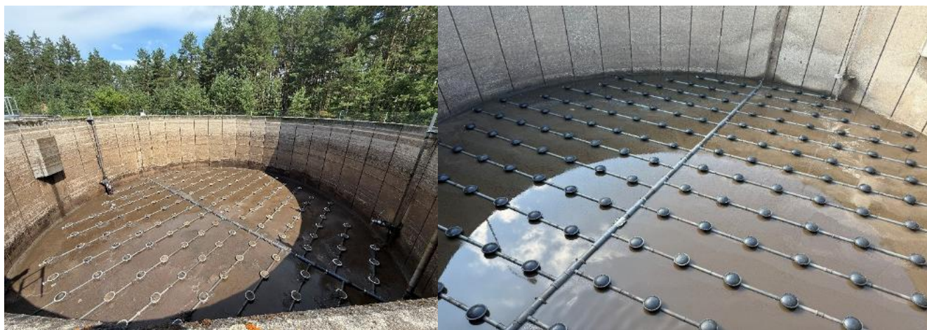
13 pav. Varėnos miesto valymo įrenginiuose sutvarkyti aerotankai
